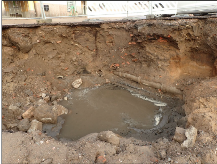
Koillisnurkkaa sen jälkeen kun siellä olleet betonikaivot oli poistettu
