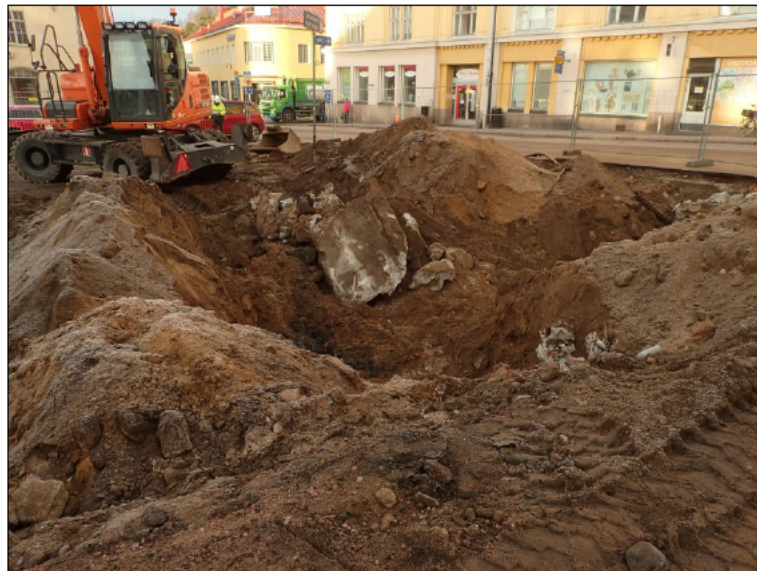
12.11. Huoltoaseman itäosassa saastuneen maa-aineksen kaivamista, öljykaivon kohdalla sy- vän kaivettu monttu. Pohjalla öljyä ja vanhoja viemäriputkia.
