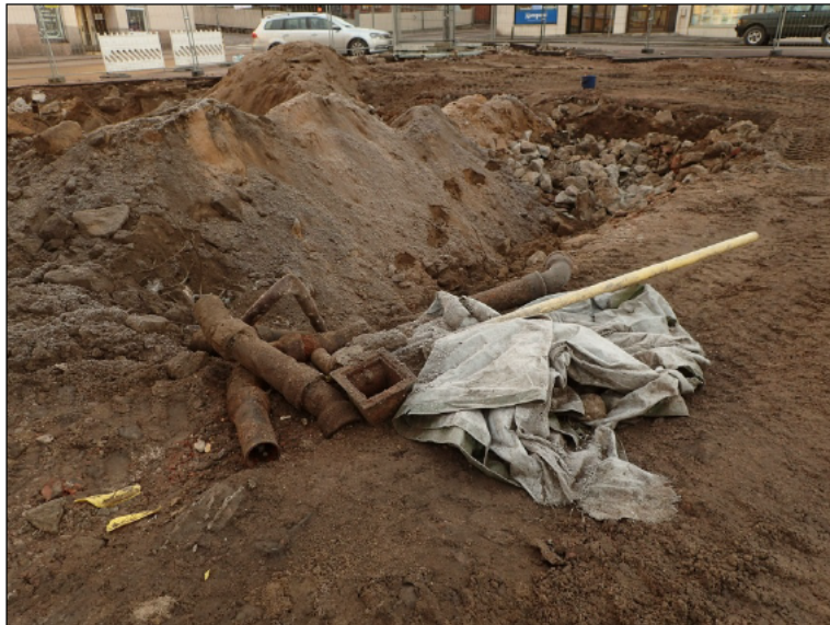
Vanhan huoltoaseman eteläreunaa, johon kasattu sen keskeltä esiin kaivettuja viemäriputkia.
