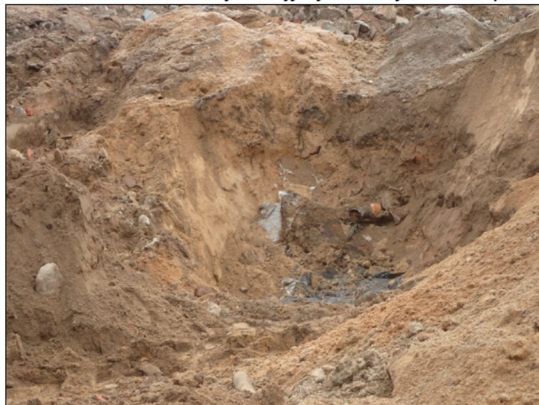
12.11. Huoltoaseman itäosassa saastuneen maa-aineksen kaivamista, öljykaivon kohdalla sy- vän kaivettu monttu. Pohjalla öljyä ja vanhoja viemäriputkia.
