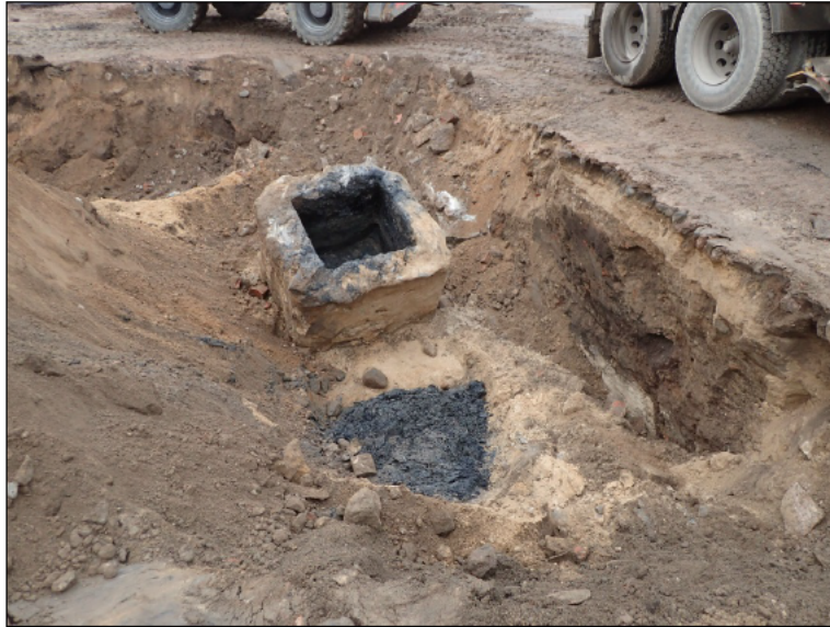
Edellisen kuvan montusta nostettu öljykaivon betoninen pohja alueen kaakkoiskulmassa.
