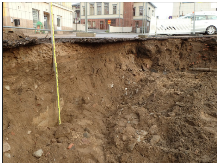
Betoniperustan takana olevaa maakerrosta Rihkamakadun eteläreunan alla.
