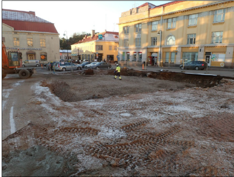
Huoltoaseman jäänteet on purettu ja saastuneet maat poistettu. kaivantoa on aloitettu täyttämään 23.11.2015
