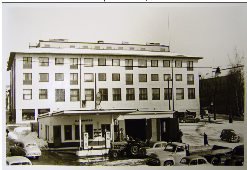
Huoltoasema ennen purkamista, oletettavasti v. 1956
