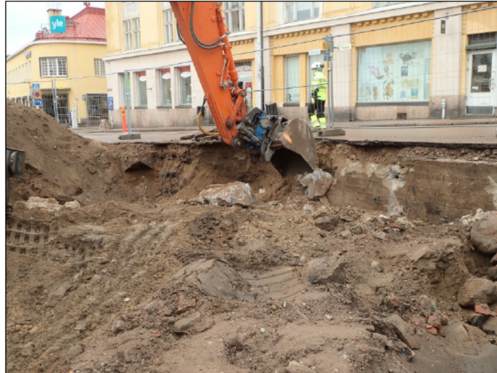
Rihkamakadun varren pohjoisseinämältä kauhotaan pois betoniperustaa.
