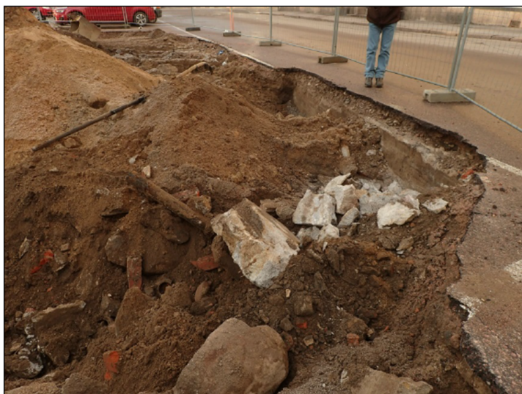
Huoltoaseman pohjoisreunaa Rihkamakadun varrella ja betoniperustaa asfaltin alla.
